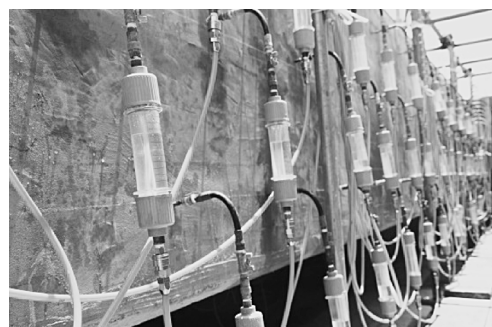
図8 亜硝酸リチウムの圧入による補修
