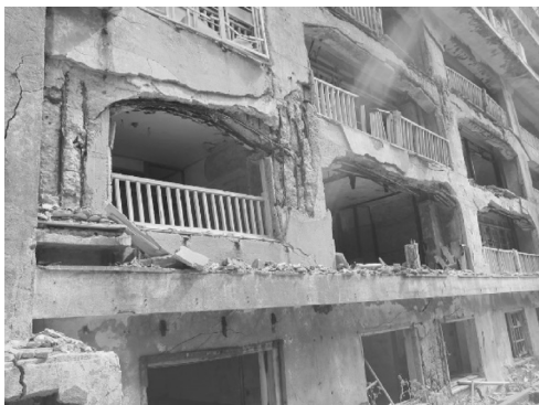
図6 塩化物イオンによる鉄筋の腐食と断面欠損（右）
