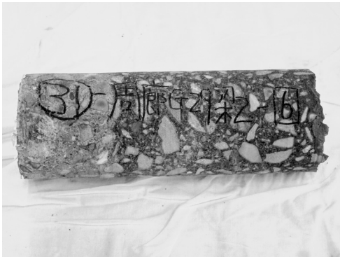
図4 フェノールフタレインによる 中性化深さの測定（左が表面付近）
