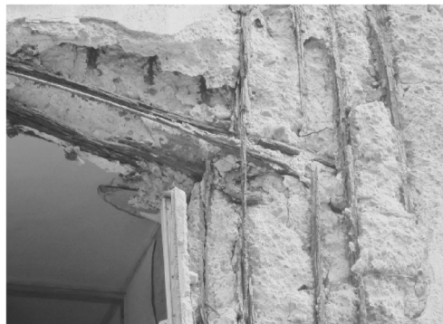
図6 塩化物イオンによる鉄筋の腐食と断面欠損（右）
