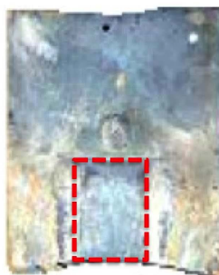
図1 姫路城大天守のいぶし瓦。点線で囲った四角部が風雨に直接曝されてきた箇所、周囲と色が異なる。
